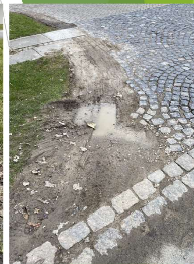
Brosten i kurve, manglende chaussesten i kurve Manglende afgrænsning af køreareal
