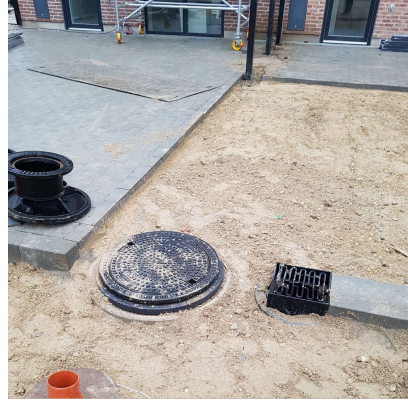
1. Placering af dæksler - Udfordringer med omkringliggende belægninger
