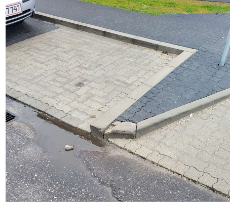
2. Kantstenslængder og placeringer - problemer med påkørsler
