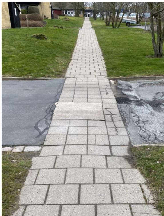
3. Forkert valg af materialer - Problemer med holdbarheden af anlægget
