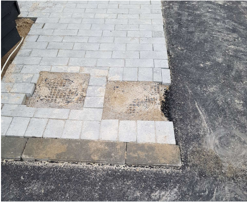
1. Placering af dæksler - Udfordringer med omkringliggende belægninger
