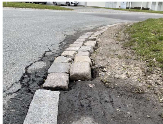
Brosten i kurve, manglende chaussesten i kurve Manglende afgrænsning af køreareal
