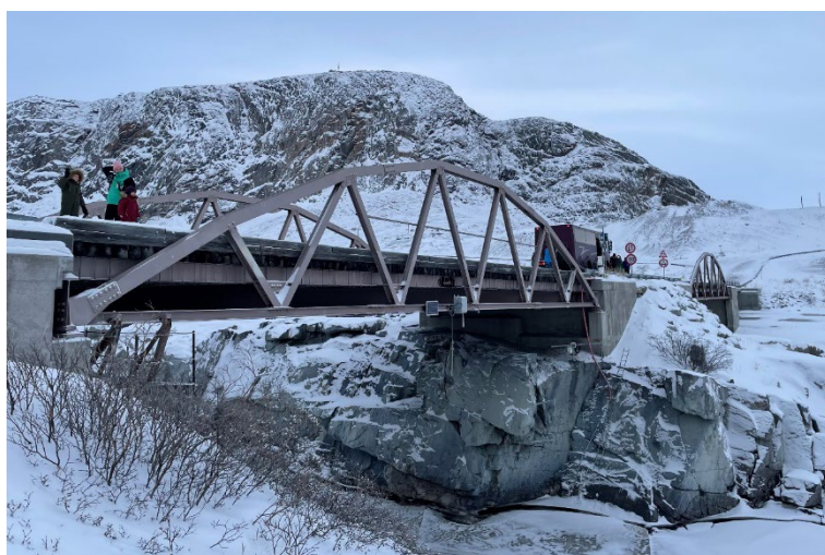
Figur 1: Buebro af stål, formentligt opført i 1940'erne.
