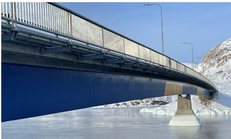
Figur 4: Billede af broen over Ulkebugten. Den sidehængte gangbro blev monteret i 2019
