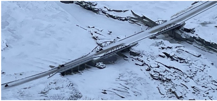
Figur 2: Oversigtsbillede af de tre broer i Kangerlussuaq. Bemærk den nye bro længst til venstre opført af armeret beton som erstatning for den bro, der skyllede væk.
