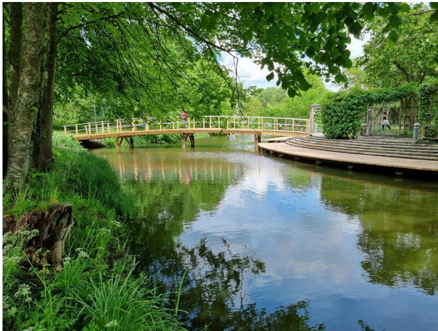
Fig. 1: Træbro fra 2022 i "Eventyrhaven" i Odense centrum. Lavet i egetræ/greenheart.
