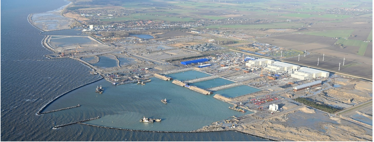
Tunnelfabrikken ved Rødbyhavn med arbejdshavn.
