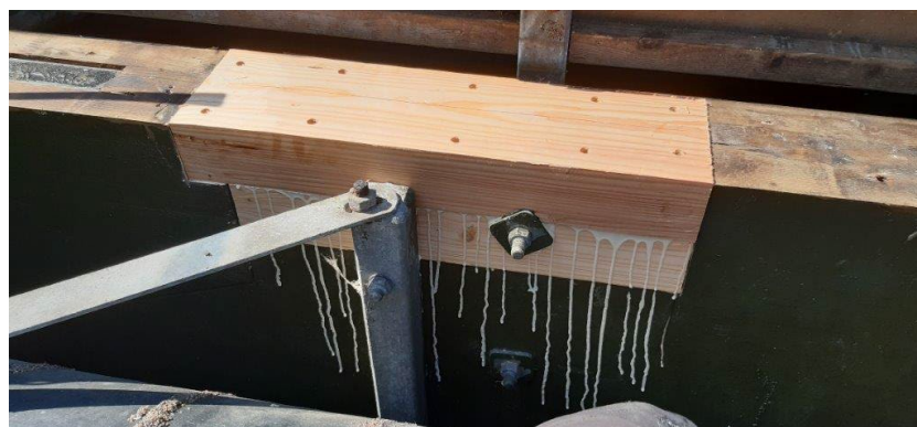
Fig. 2: Træbroer kan gemme på skjulte skader. Broen her, som har vanger i limtræ(fyrretræ), fik nye dækplanker i 2019. I den forbindelse fandt vi et par rådkader i limtræet, som blev repareret.
