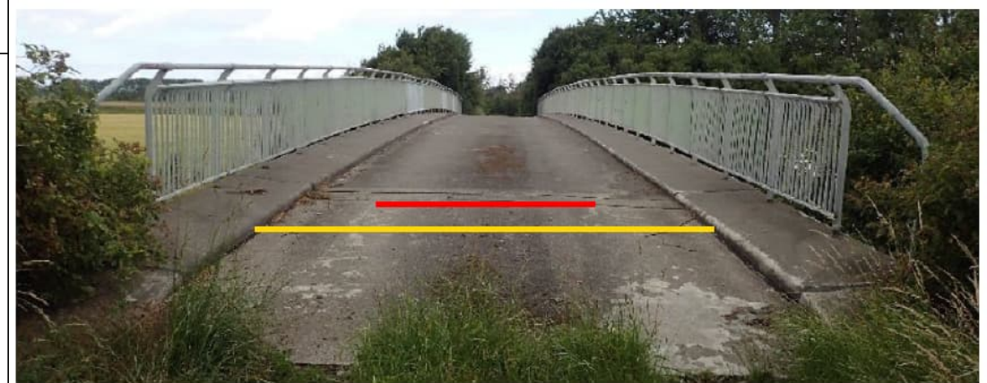
Figur 9: Skitsering af lastspor for de forskellige passage typer. Gul: Normal passage, betinget passage type 1 og 2, Rød: Betinget passage, type 3.
