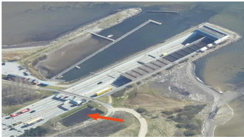
Figur 9 Åbent regnvandsbassin ved Nordre Portal.
